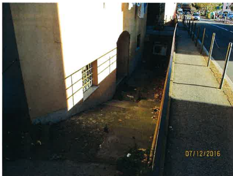
Fot. 1 – rampa di accesso
