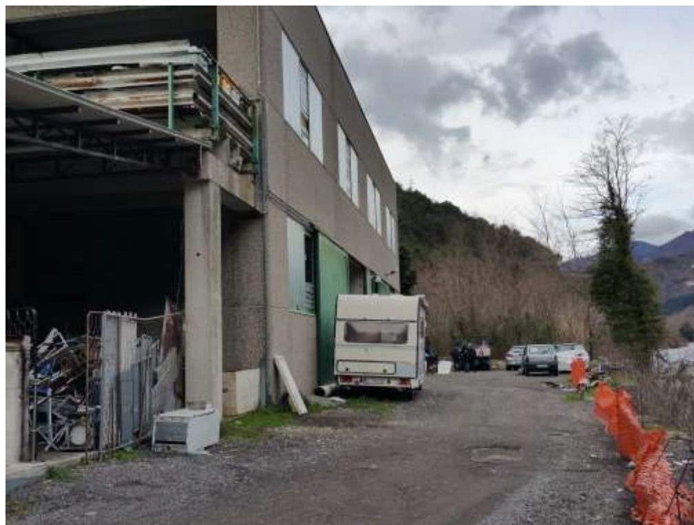
FOTO 18—PROSPETTO SUD EST
