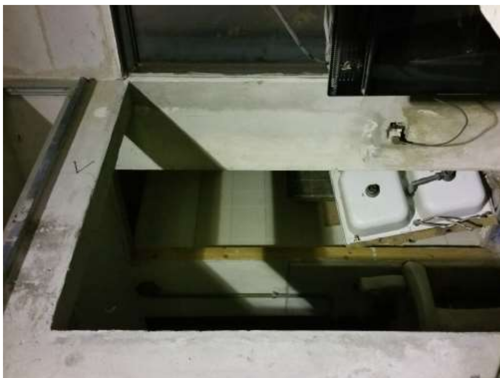
FOTO 38—SERVIZI IGIENICI FRA LOCALE 5 E LOCALE 7
