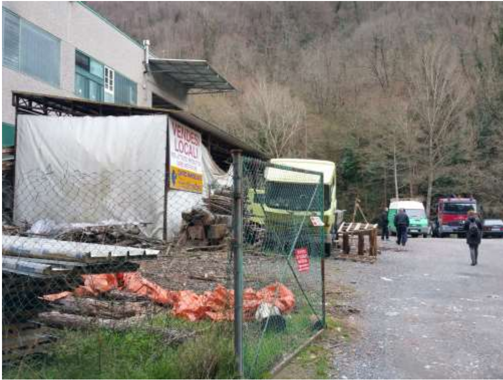
FOTO 13—ACCESSO AL SUB 8 ATTRAVERSO I TERRENI
