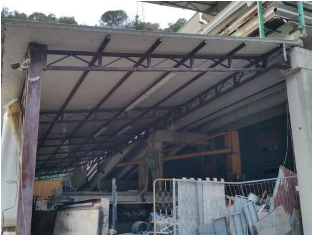
FOTO 19— SPAZIO SOTTOSTANTE LA RAMPA DI ACCESSO AL PIANO 1
