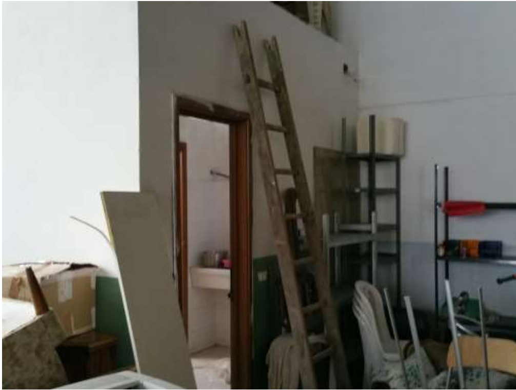
FOTO 5—LOCALI IGIENICI SUB 2 LOCALE “1”
