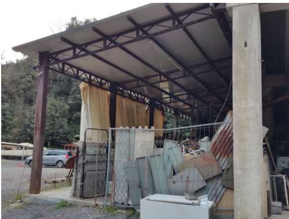
FOTO 20—PARTICOLARE TETTOIA ABUSIVA
