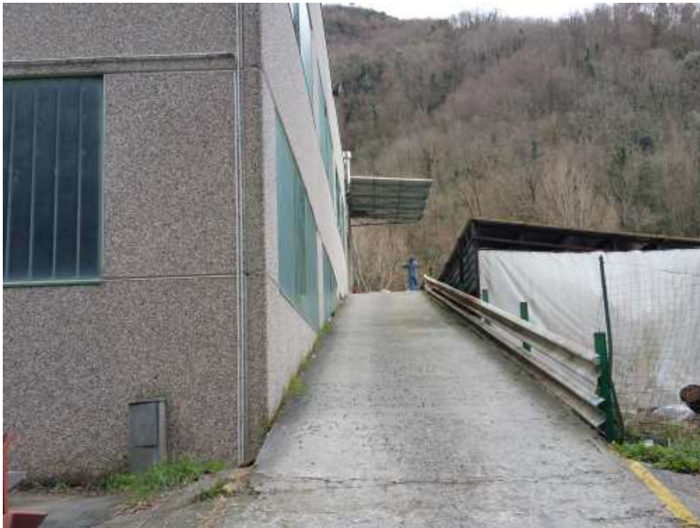
FOTO 3—RAMPA DI ACCESSO AL PIANO 1 (ALTRA PROPRIETA')
