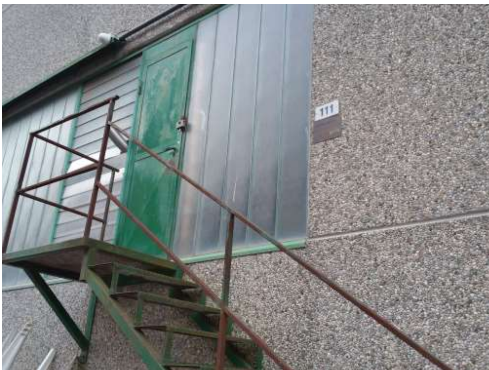
FOTO 45—SCALA ESTERNA ABUSIVA DI ACCESSO ALL'UFFICIO
