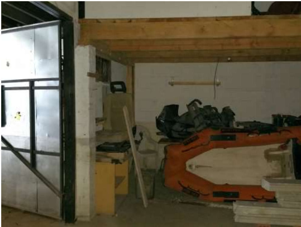
FOTO 38—LOCALE 8 E SOPPALCO ABUSIVO
