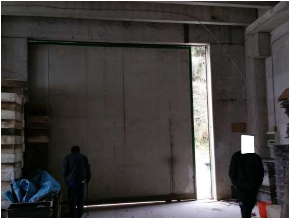
FOTO 11— ALTRO ACCESSO SUB 2 ACCESSO "2"
