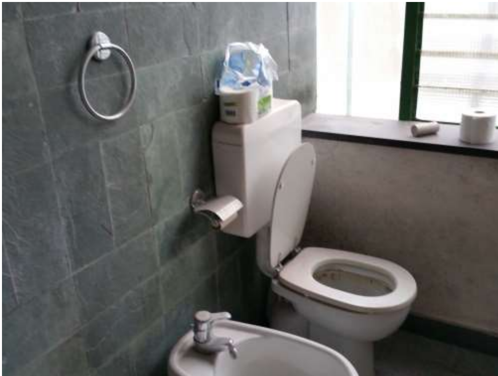
FOTO 29— LOCALE IGIENICO UFFICIO
