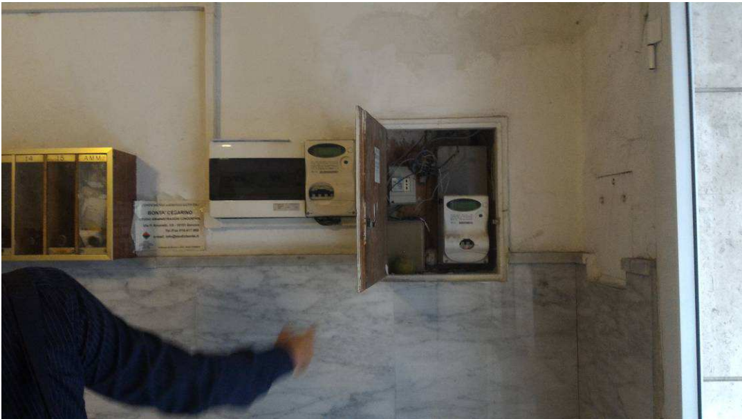
Fotografia n° 7 - dettaglio contattori ENEL
