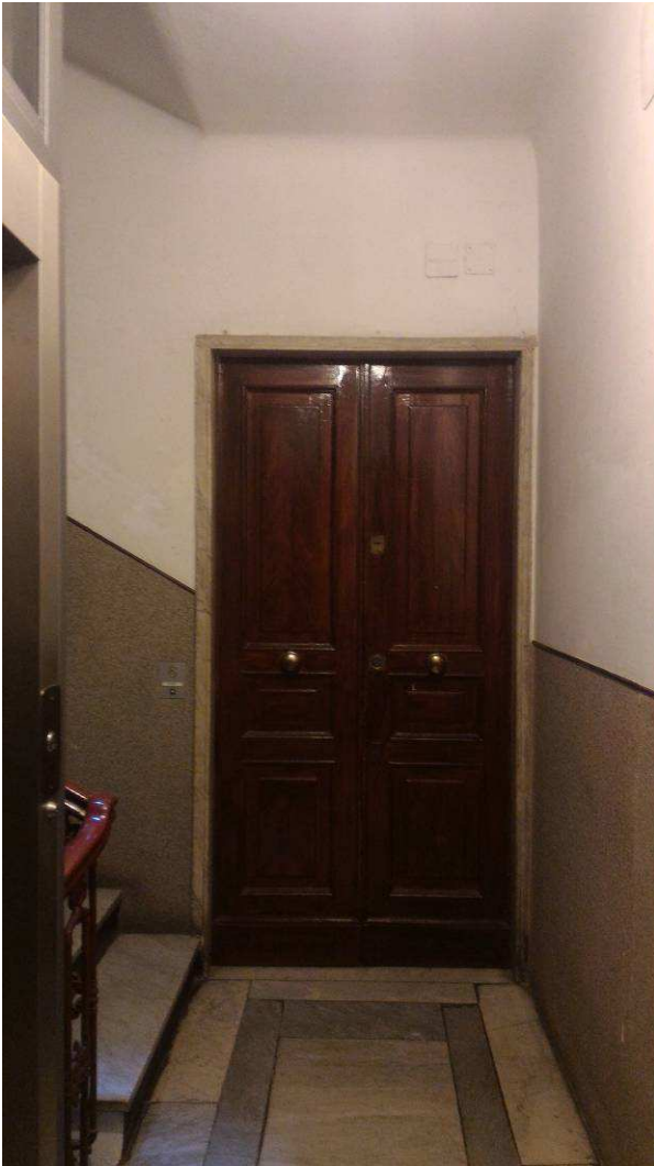
Fotografia n° 11 – vista ingresso interno 6
