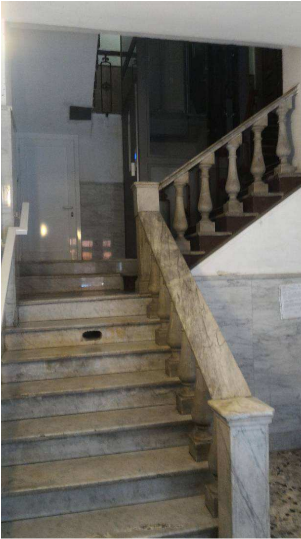
Fotografia n° 9 – rampa d’accesso P. terra
