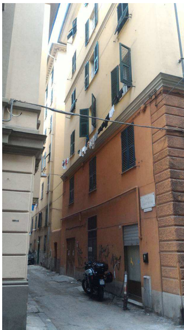
Fotografia n° 4 – distacco su vico Grattoni
