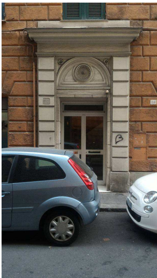
Fotografia n° 3 - vista ingresso civ. 10
