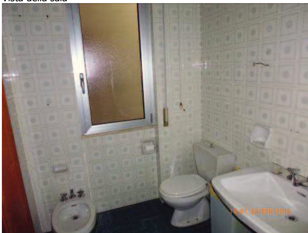
Vista di un bagno
