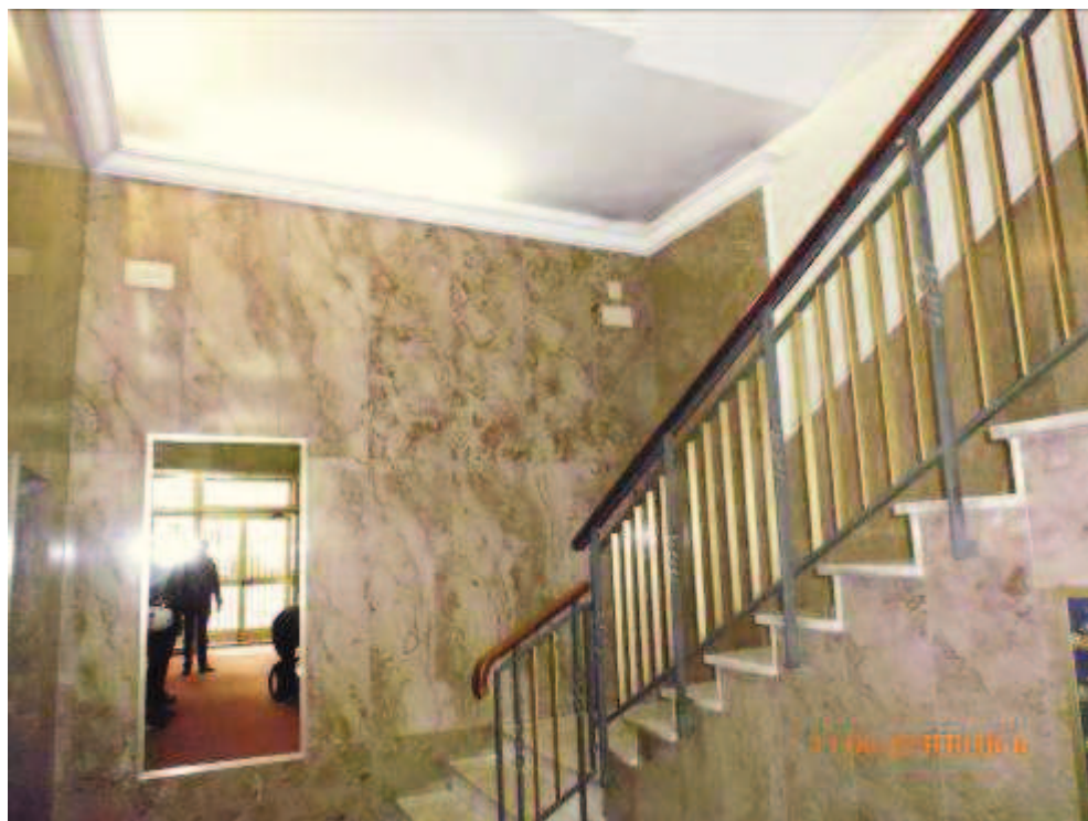
Vista dell'atrio dell'edificio
