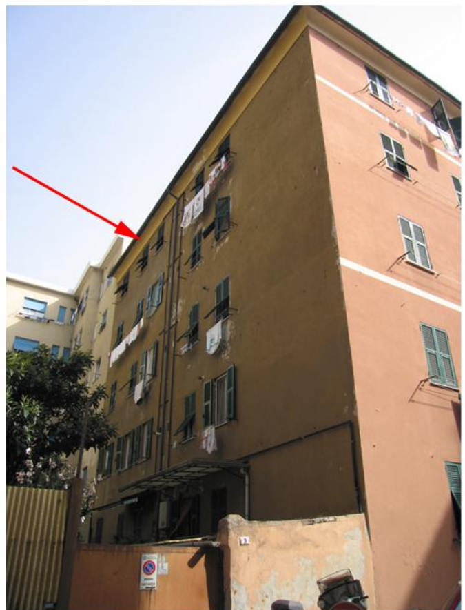
Foto 2: Finestre appartamento int 10 su distacco
