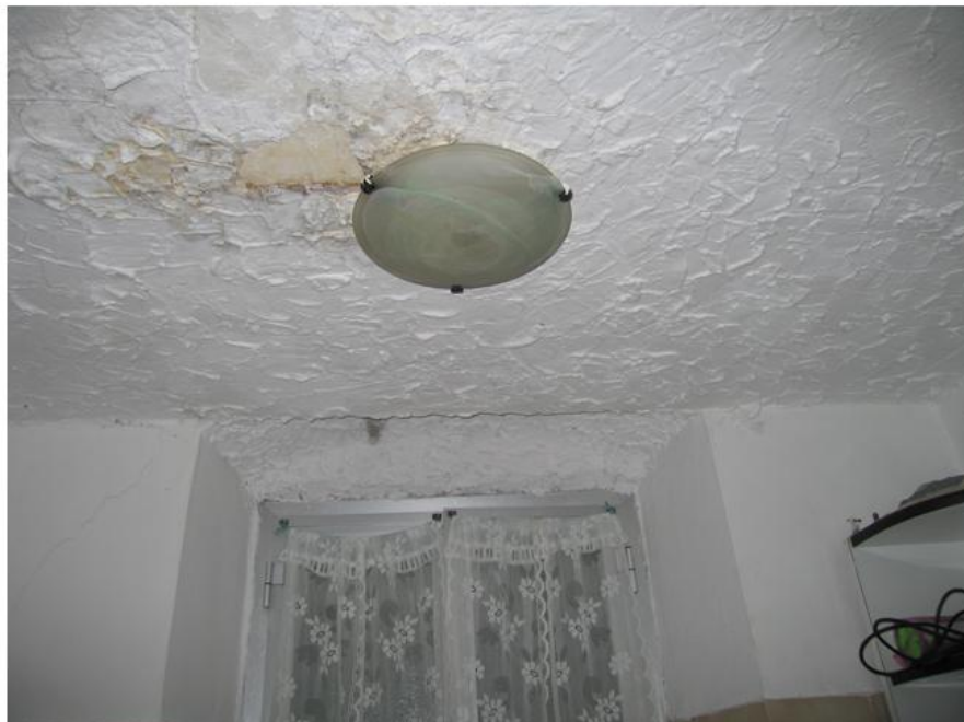
Foto 22: Particolare soffitto bagno
