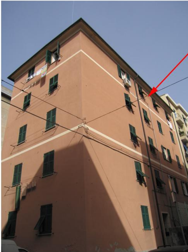
Foto 1: Finestre appartamento int 10 su via Adamello
