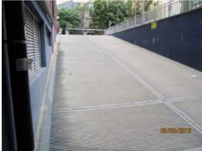
Fot. 8 – rampa di accesso
