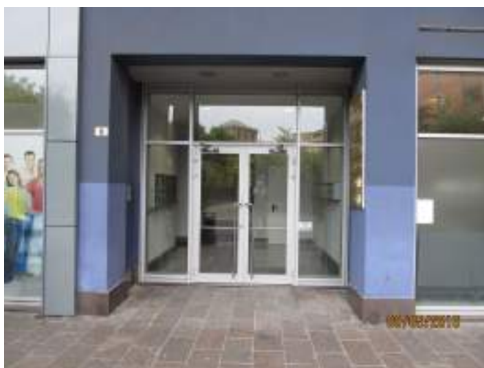
Fot. 2 – portone d'ingresso
