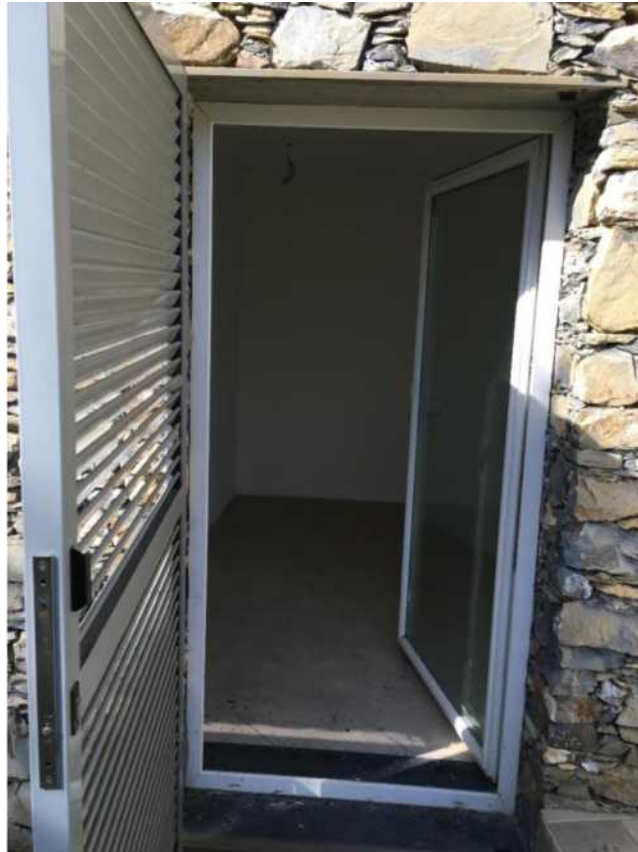
Foto 12 – Locale tecnico esterno
