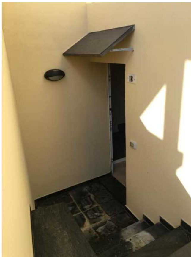
Foto 1 – Ingresso civ. 18 (piano 1SS)
