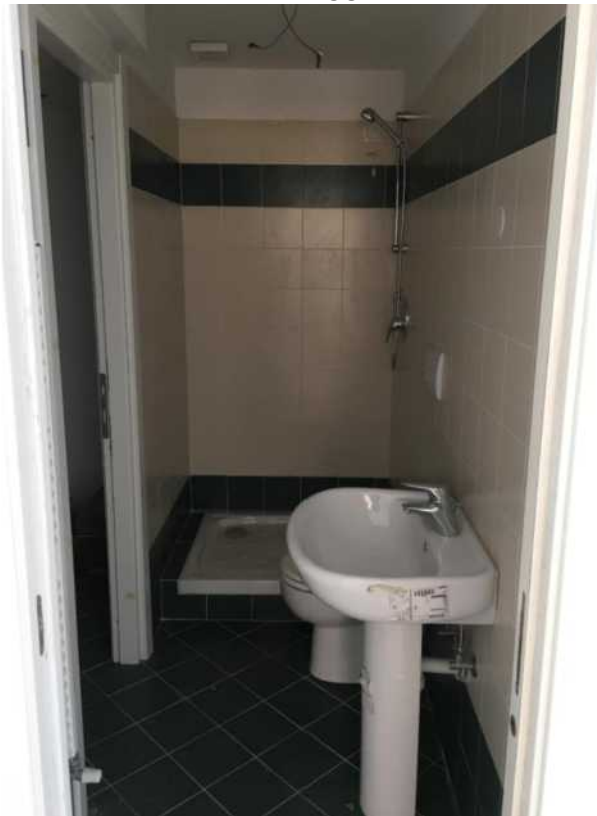
Foto 4 – Bagno Piano 1SS
