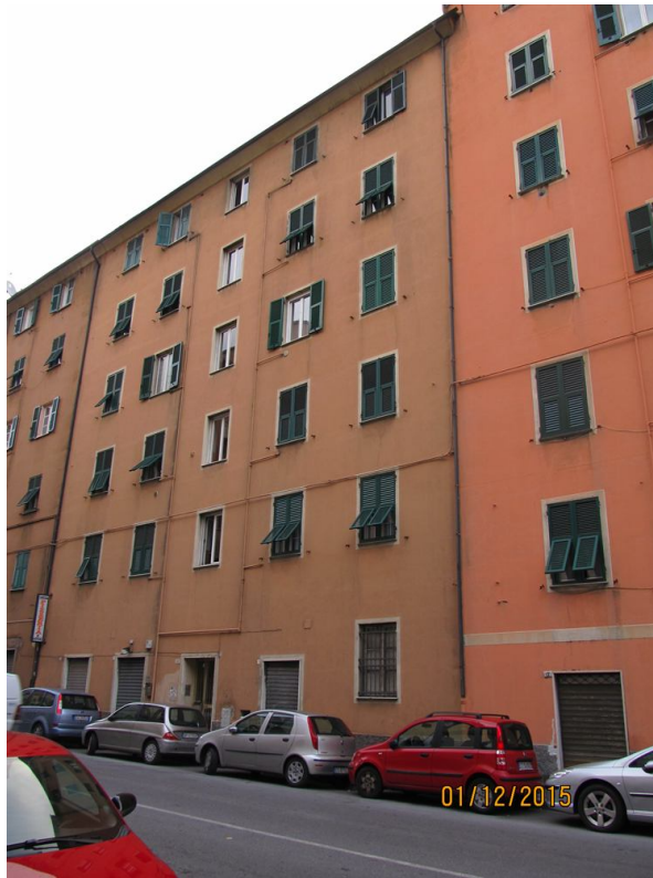
Fot. 1 – facciata su Via San Bartolomeo del Fossato
