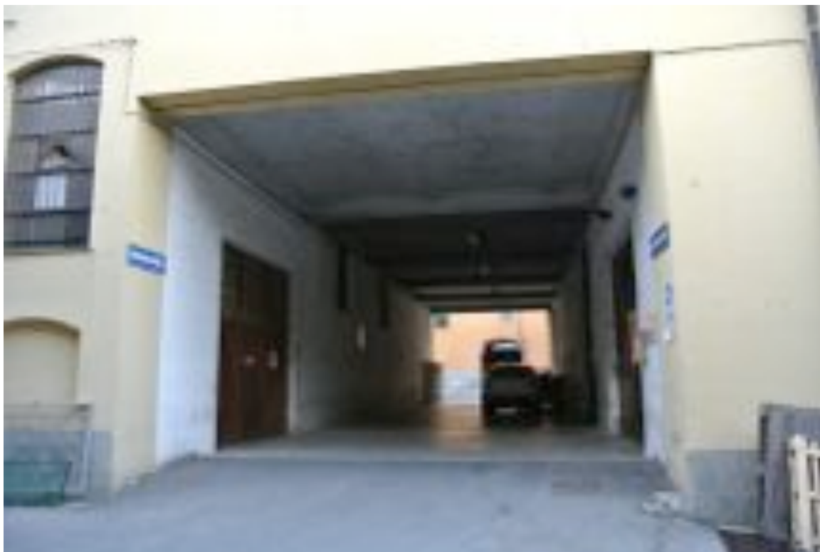
FOTO 5 - Particolare accesso comune
