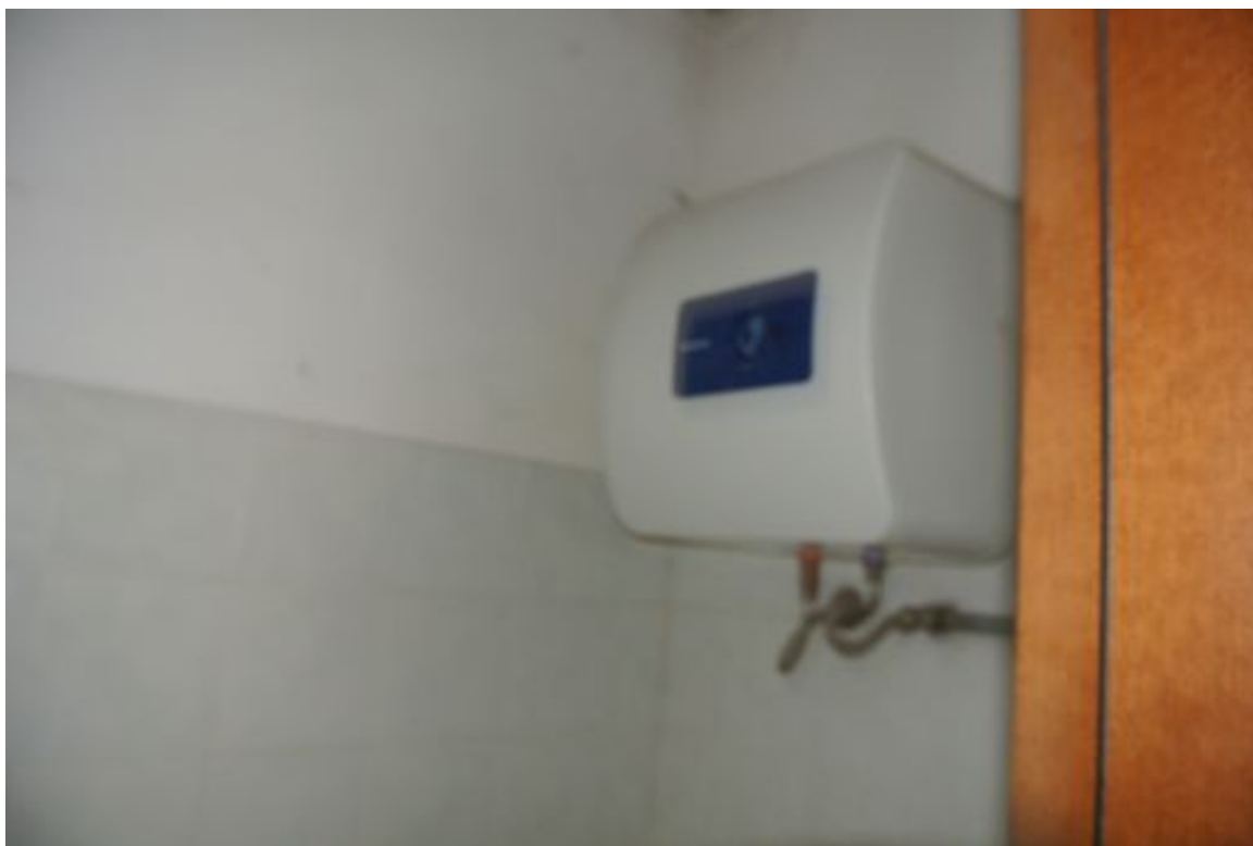
FOTO 19 - Boiler elettrico
