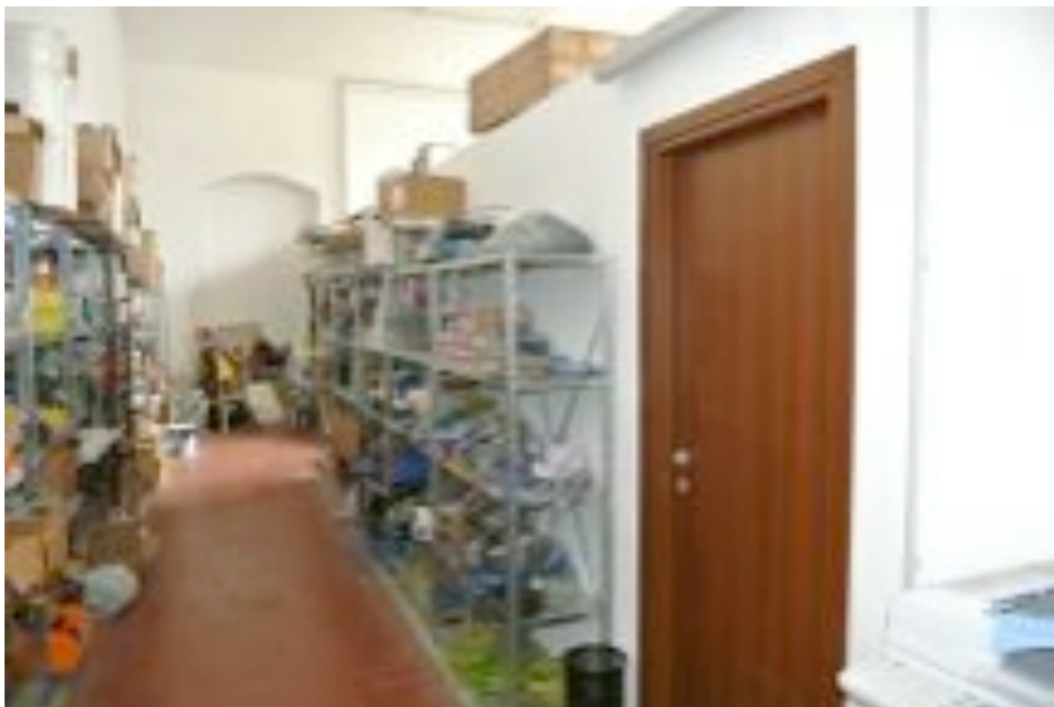
FOTO 14 - Uffici con pareti in cartongesso e pavimentazione in gres
