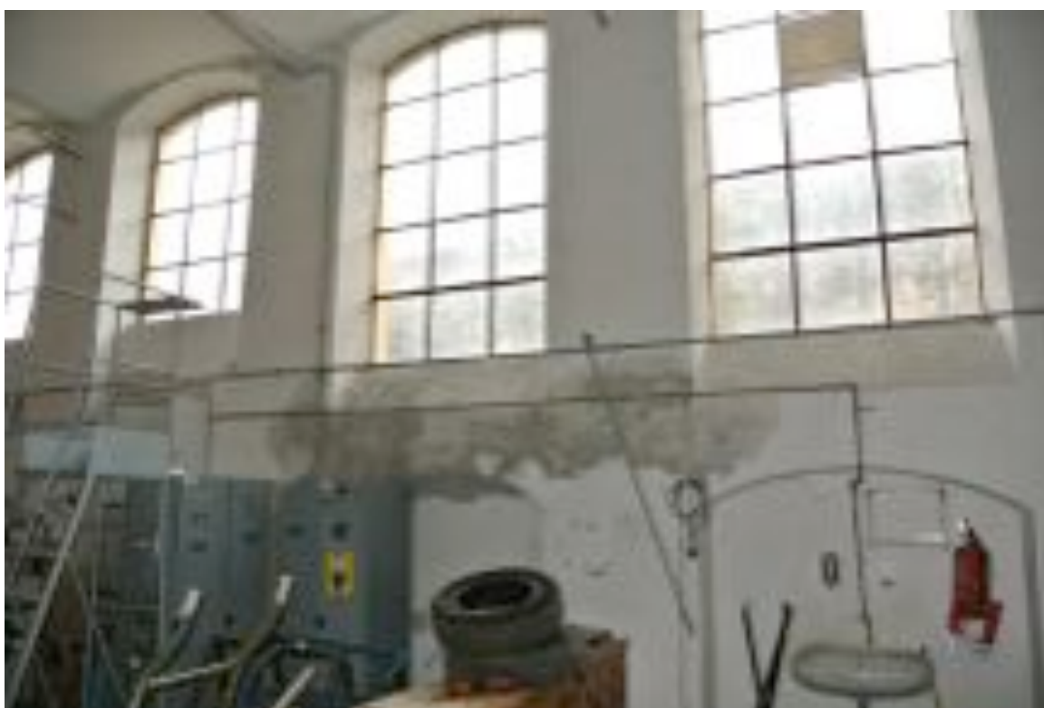
FOTO 11 - Finestre parete est prossime all'ingresso
