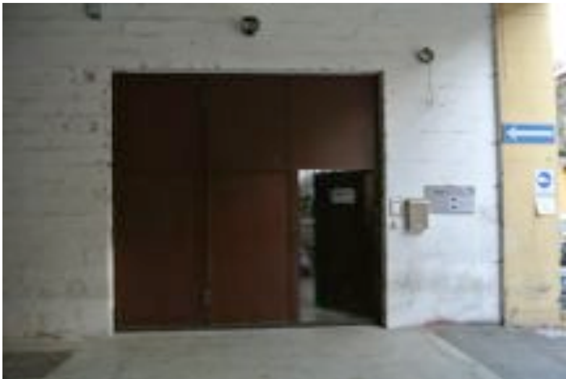
FOTO 8 - Porta di accesso all'int. 8
