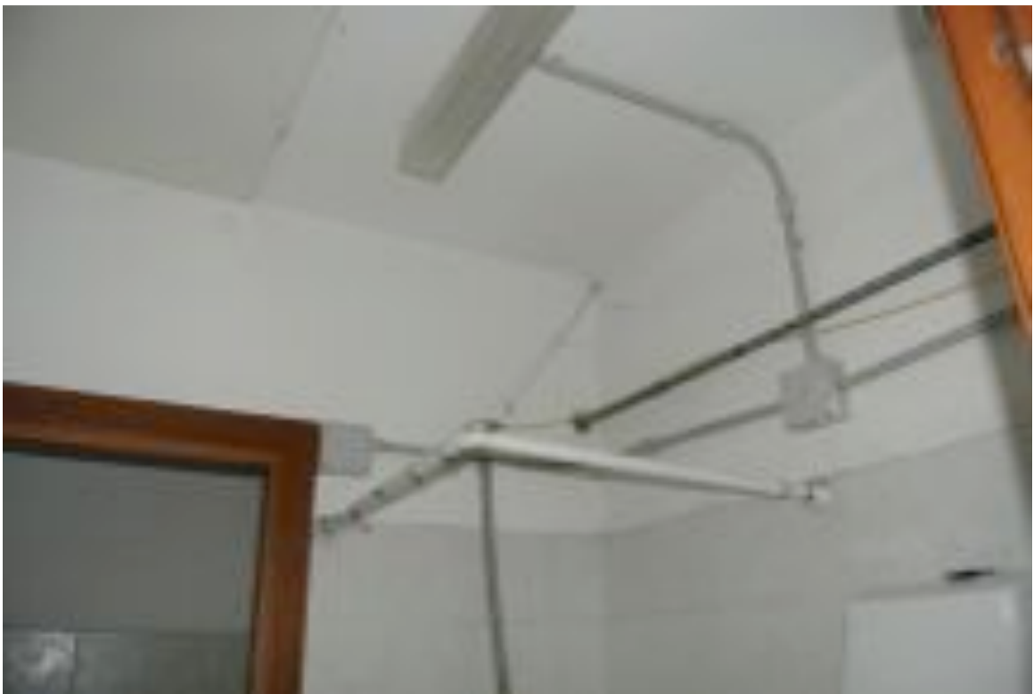
FOTO 18- Particolare soffitti WC
