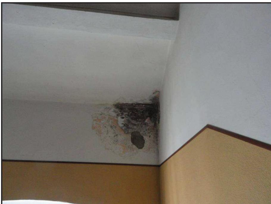
**Foto 9: particolare infiltrazioni vano scala ultimo piano**
