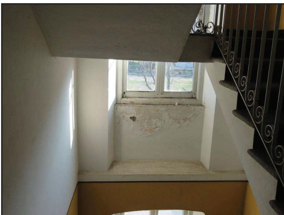
**Foto 10: particolare infiltrazioni vano scala piano intermedio**
