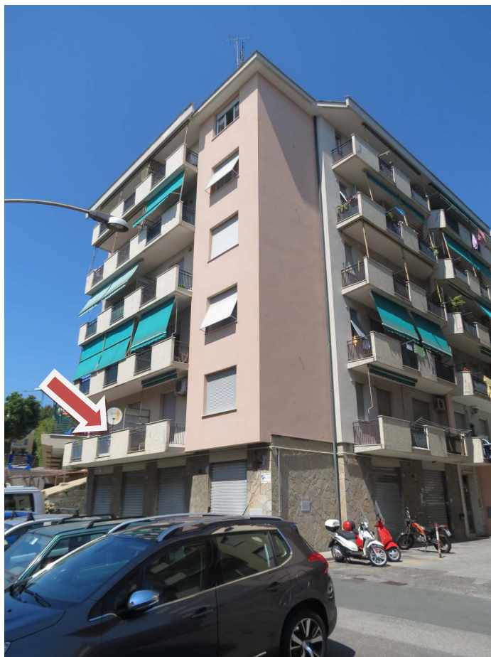
FOTO n. 1 : il condominio di via Stefano Tubino n. 117 e l'appartamento int. 2
