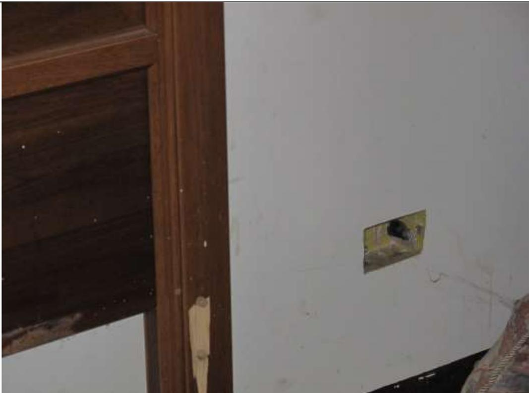
Foto 40: Particolare cassette impianti elettrici – impianti completamente da rifare
