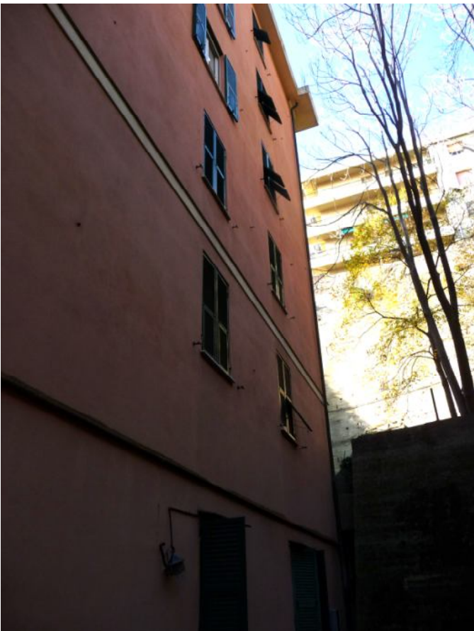
Foto 3. Il prospetto nord (retrostante)
