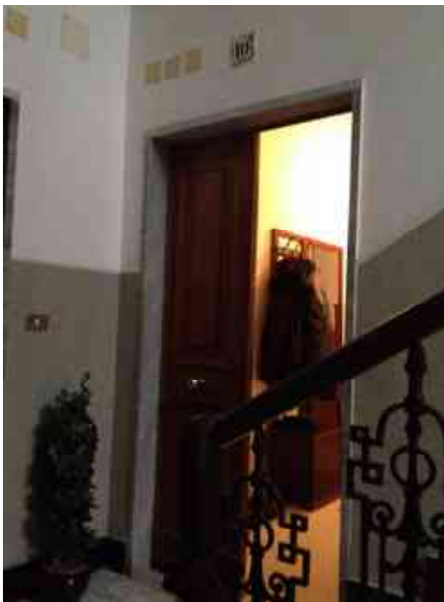
FOTO 10: Piano terzo: porta d'ingresso int. 10 sc. A.
