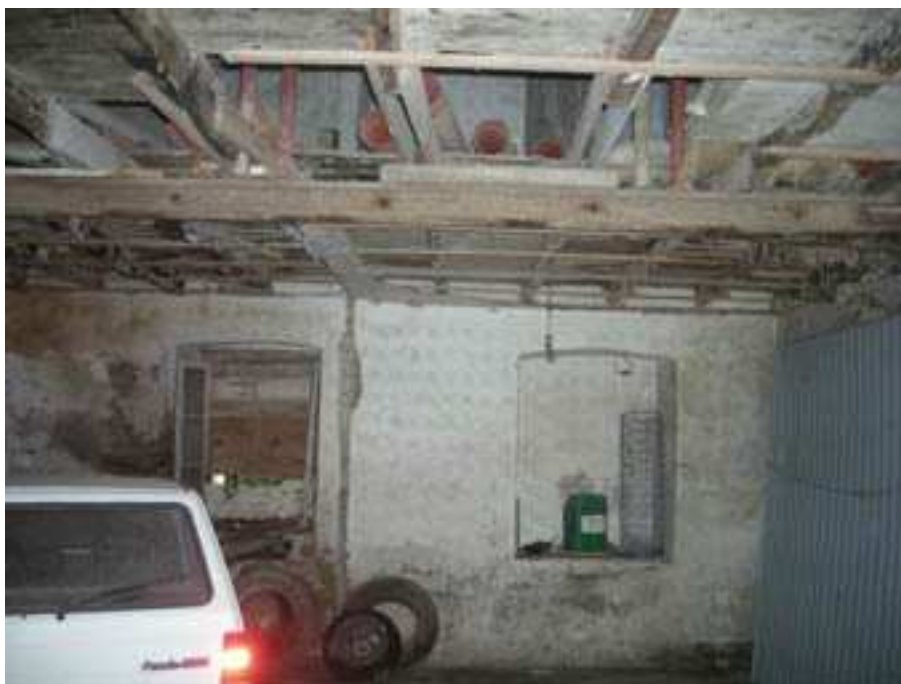
6 – Piano terra - locale di sgombero - ovest
