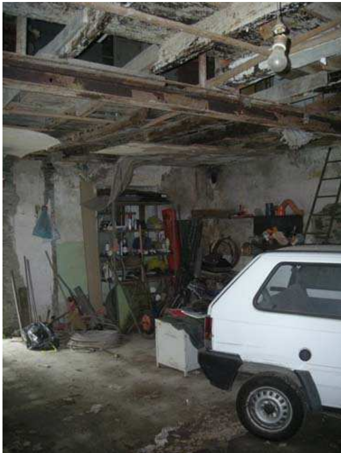
5 – Piano terra - locale di sgombero - sud est
