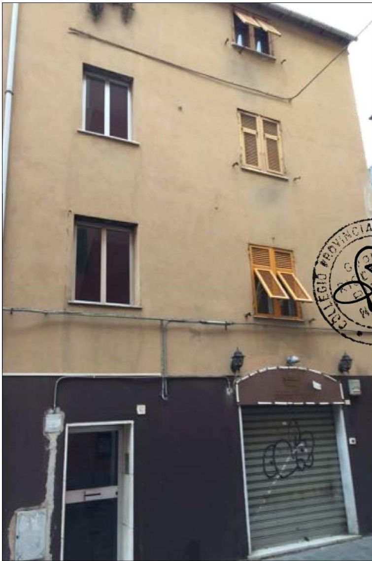
FOTO N° 1: Vista esterna immobile Piazza Albertina 6
