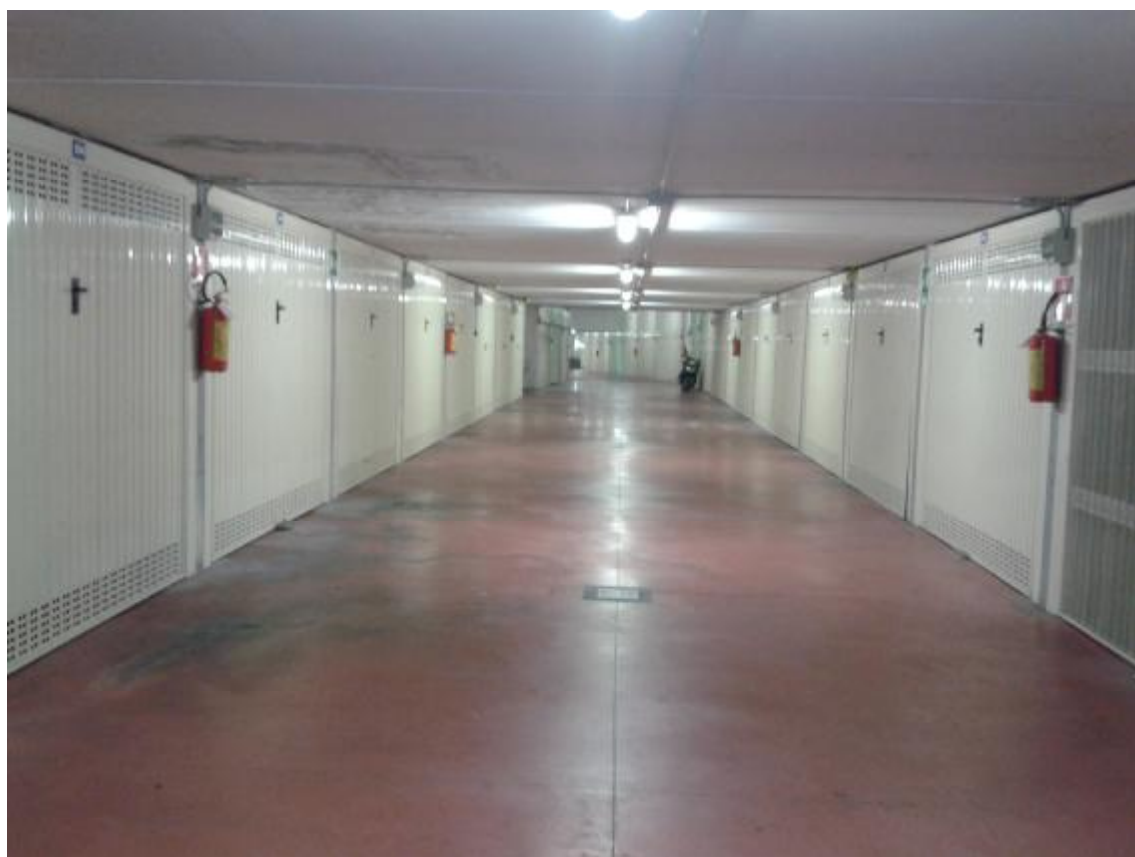
Foto n° 7 - 8 - (p. 1° interrato) - corsie di manovra
