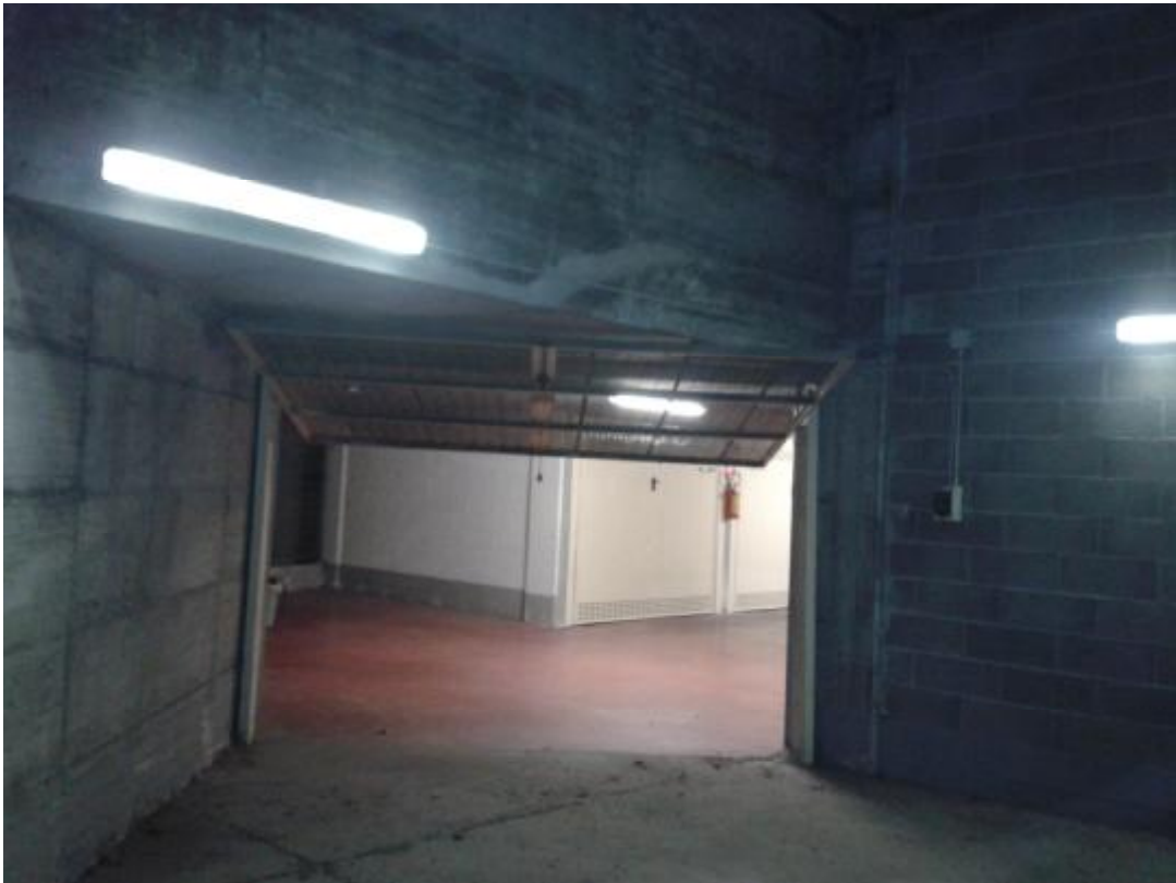
Foto n° 11 - 12 - (piano 1° interrato ) Box n° 152
