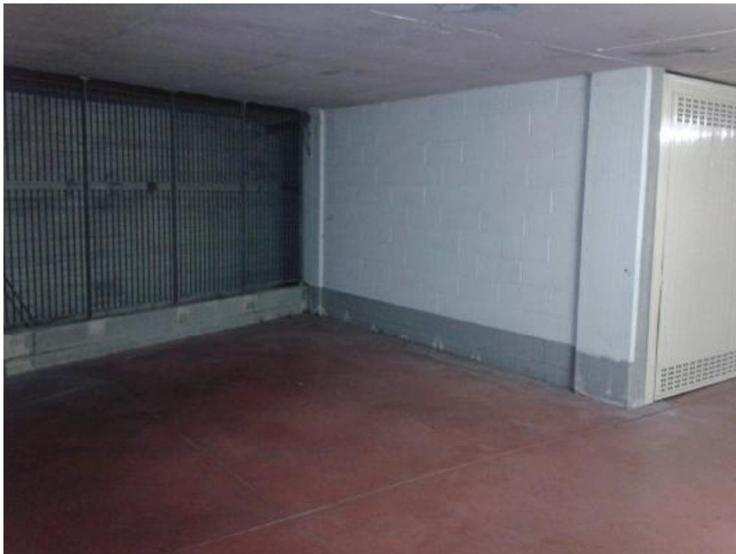
Foto n° 9 - 10 - (piano 1° interrato ) posto auto coperto n° 153
