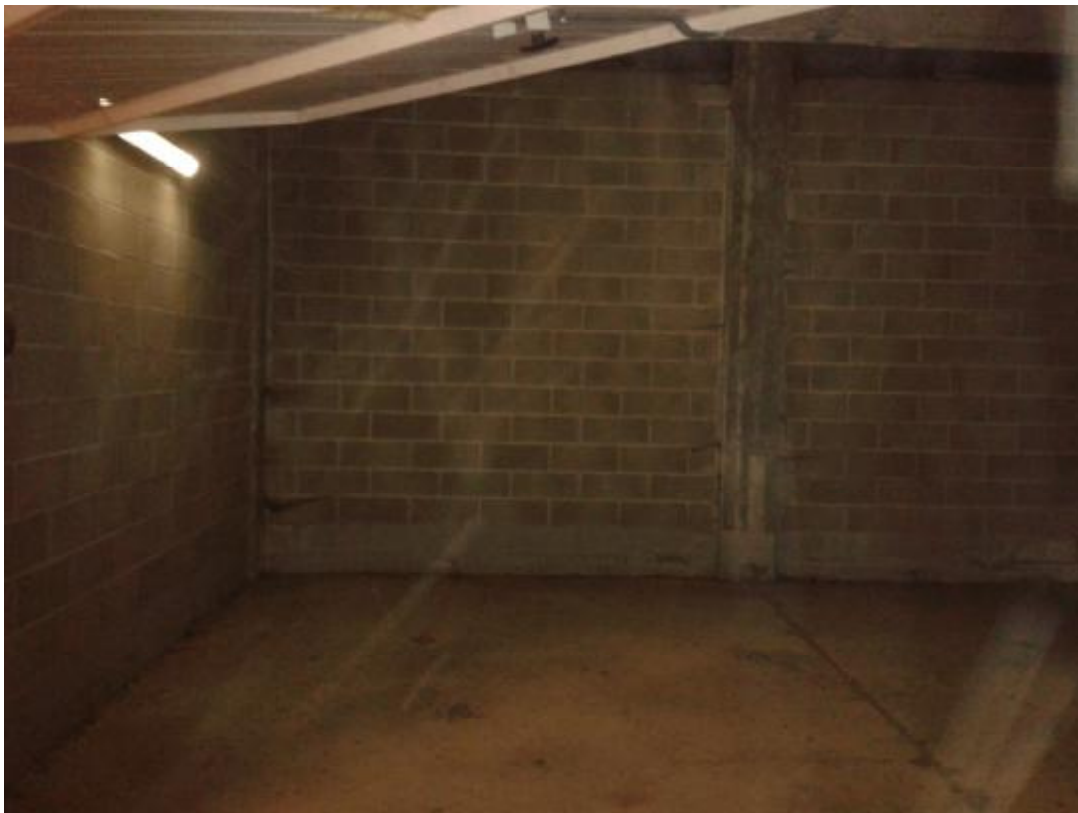
Foto n° 13 - 14 - (piano 1° interrato ) Box n° 152
