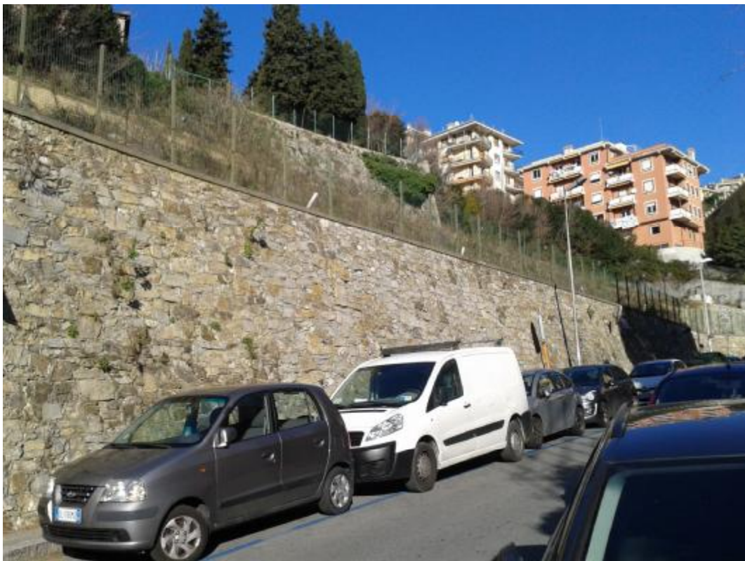
Foto n° 1 - 2 Autorimessa Via Stal I o - Via Ausonia
