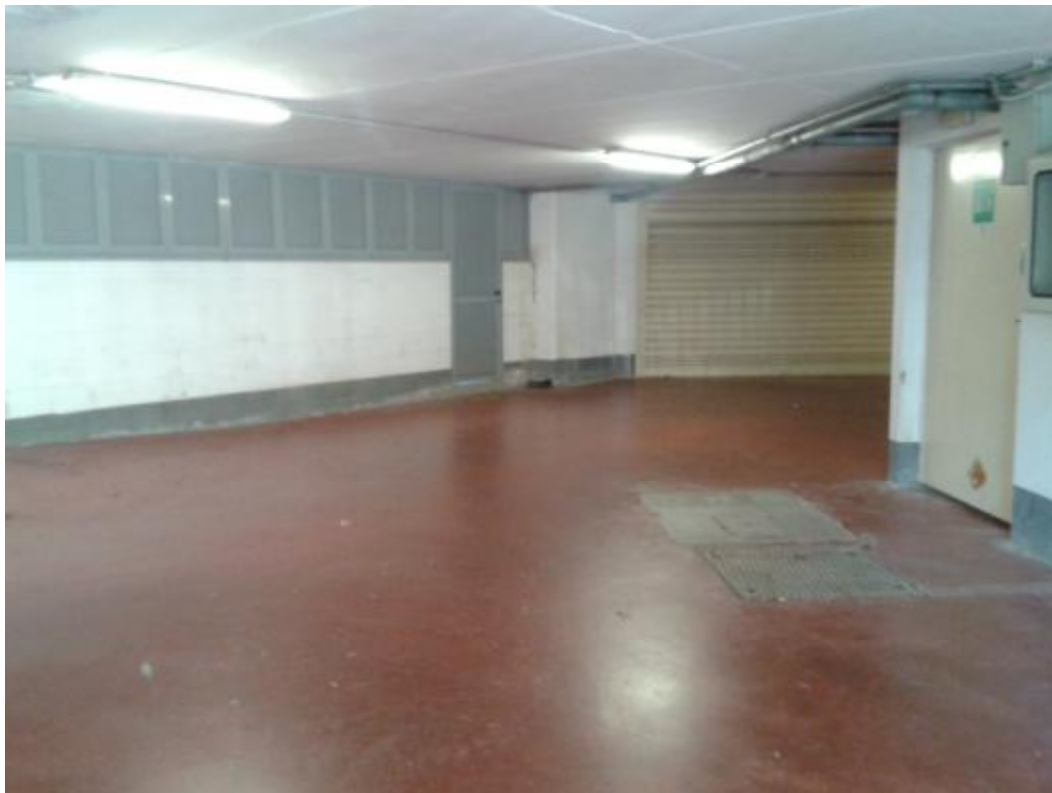
Foto n° 4 - inizio rampa elicoidale
