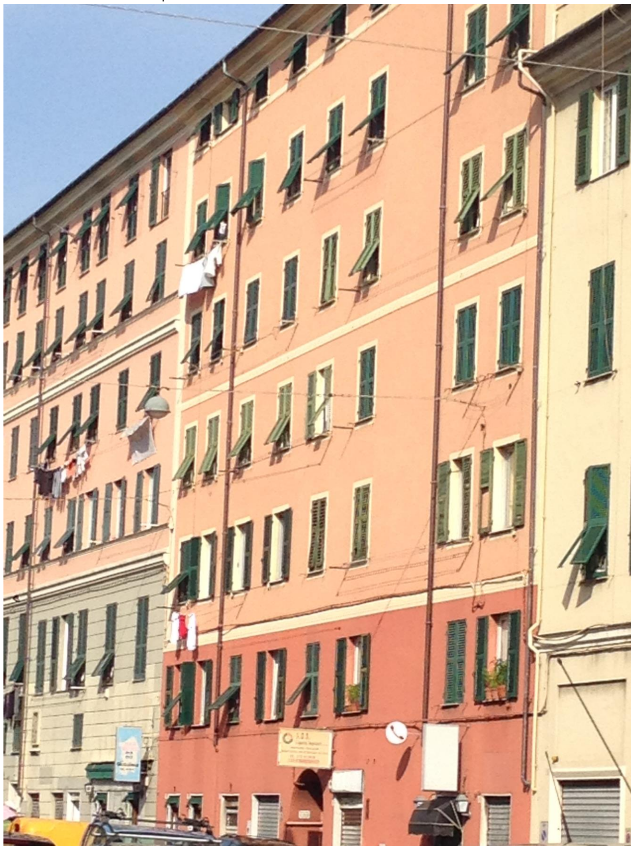
Affaccio sud su Via Sampierdarena
