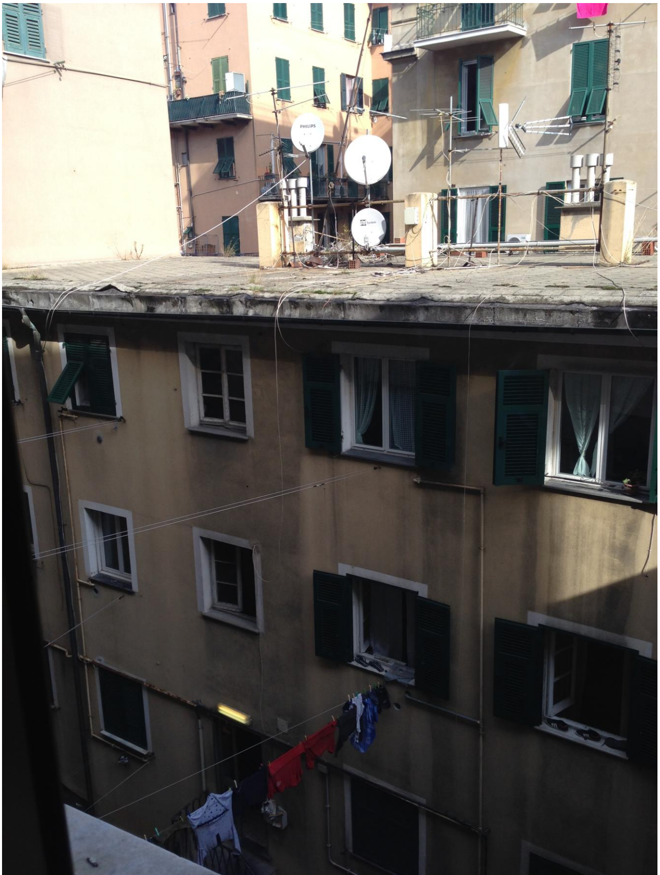
Affaccio Nord su distacco interno
