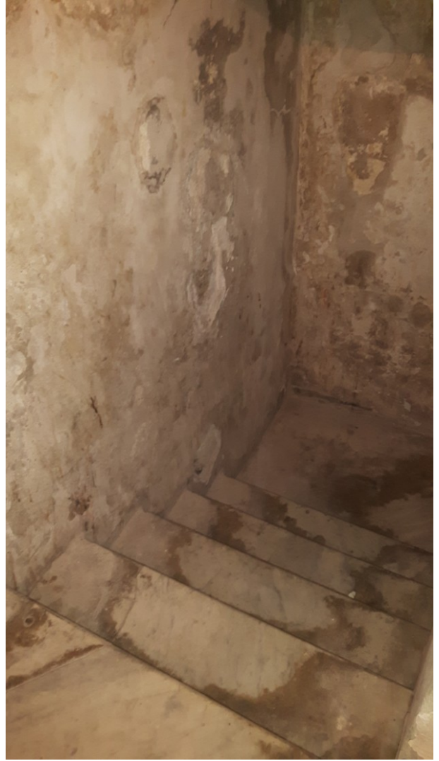
Foto 2 – Vano scala condominiale
