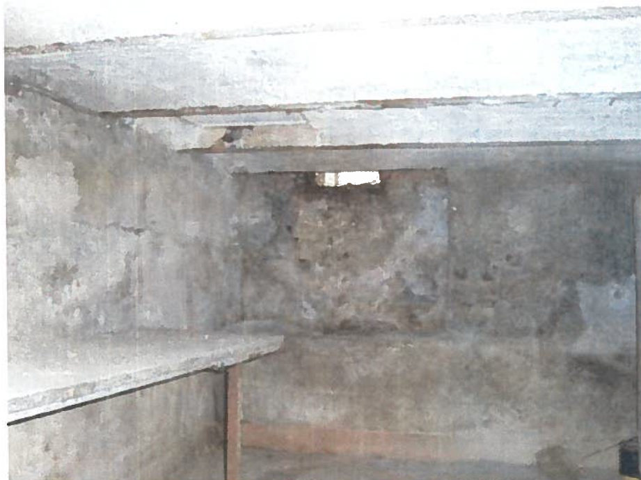
Cantina - Locale lato Est
