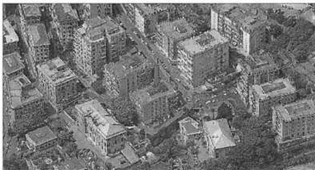
Via Col di Lana vista a est
