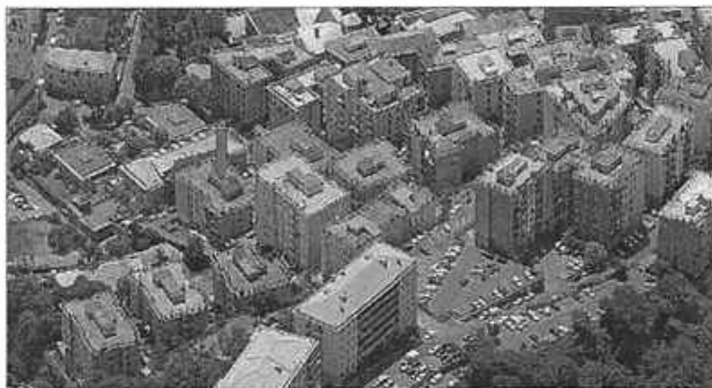
Via Col di Lana vista a sud
