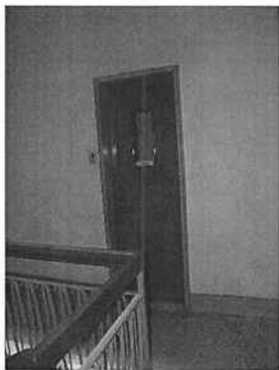
Ascensore al piano dell'interno 3
