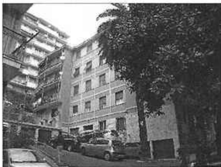
Vista del fronte principale da Via Col di Lana
