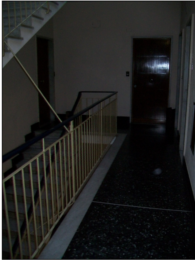
FOTO N° 6 – VANO SCALA CONDOMINIALE
