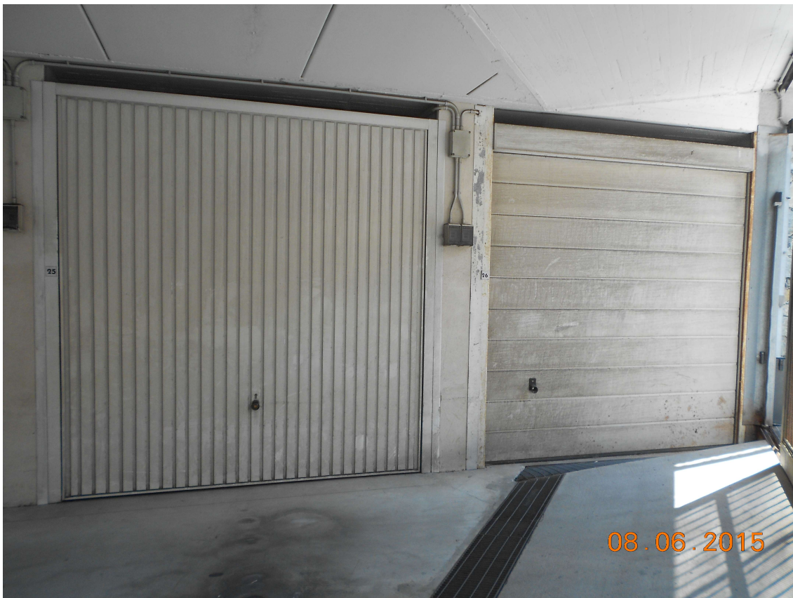
foto 3: a sinistra il box 25 (lotto 2), a destra il box 26 (lotto 3)
