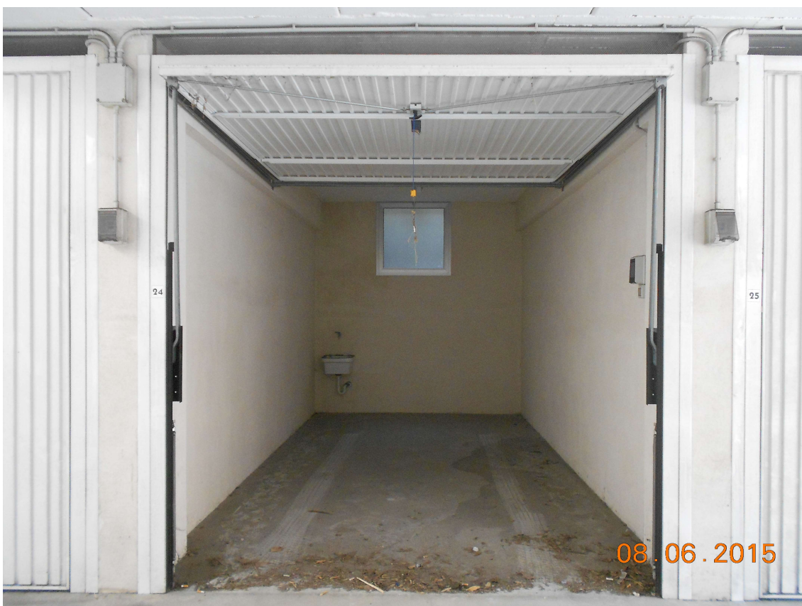
foto 4: interno. (si è potuto visionare solo l'interno del box 24 limitrofo ai due, tuttavia risultano tutti pressochè uguali).
