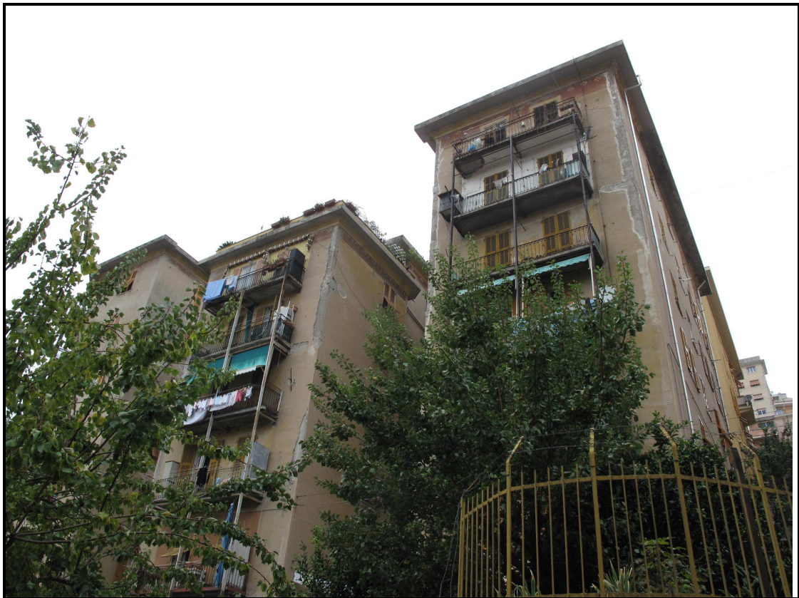
Foto 2 – prospetto sud del fabbricato
