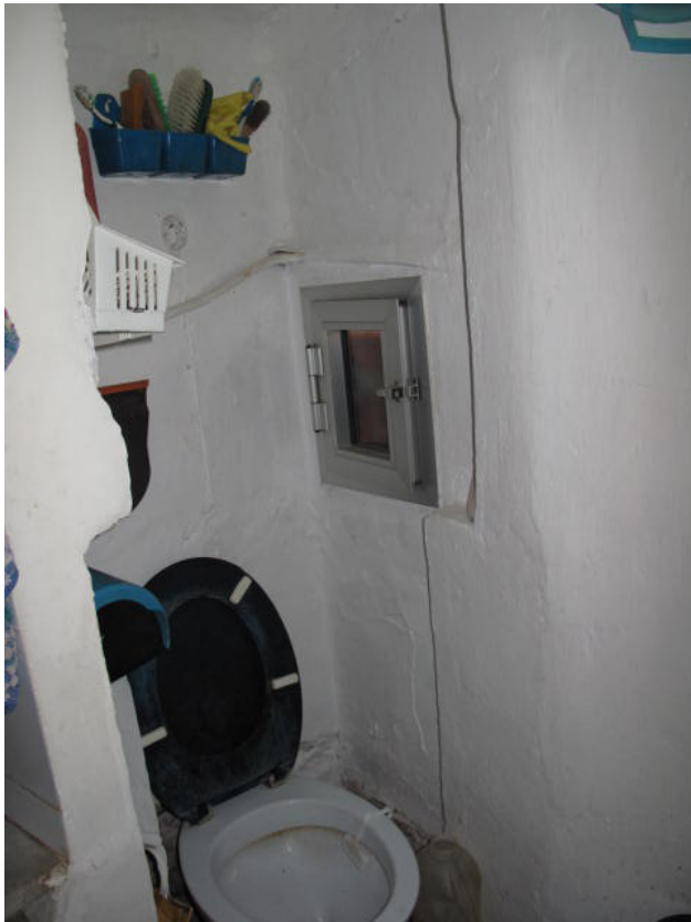
Foto 11: Latrina adiacente alla cucina
