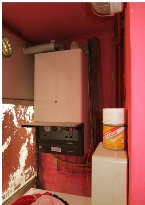
Bagno e poggiolo tamponato abusivamente; particolare della calderina con impianto di tubi esterno non coibentato
