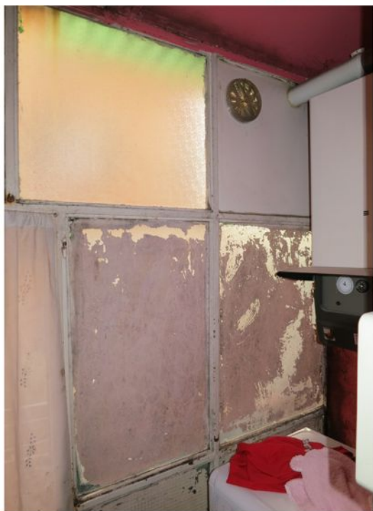
Bagno e poggiolo tamponato abusivamente; particolare della calderina con impianto di tubi esterno non coibentato
