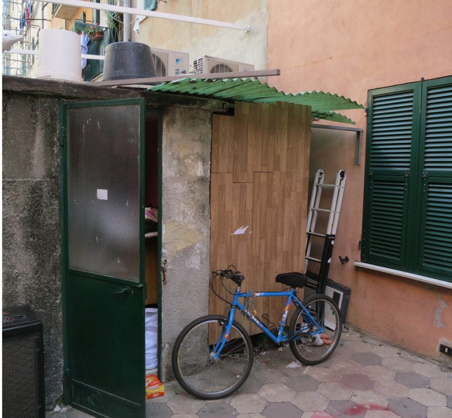
Terazzo posteriore, con il ripostiglio abusivo e il distacco tra ripostiglio e muro perimetrale.
