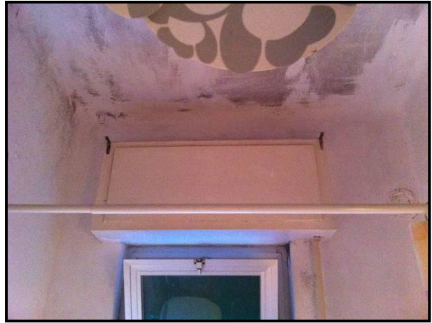
FOTO 14: Bagno, macchie al soffitto
