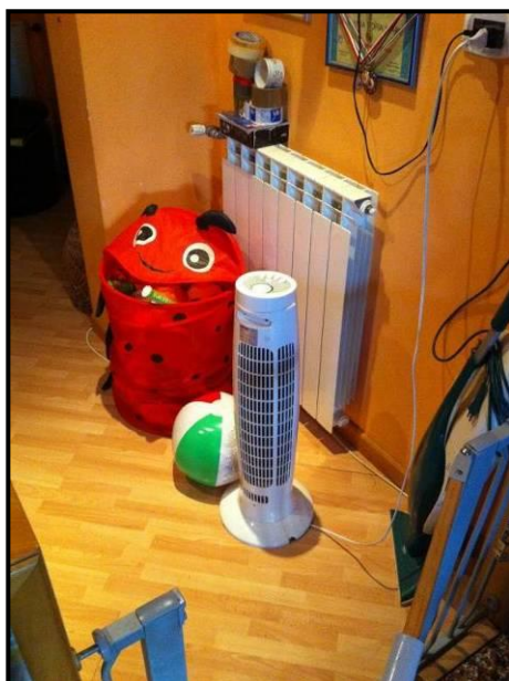
FOTO 7: Ingresso/soggiorno, pavimentazione in laminato
