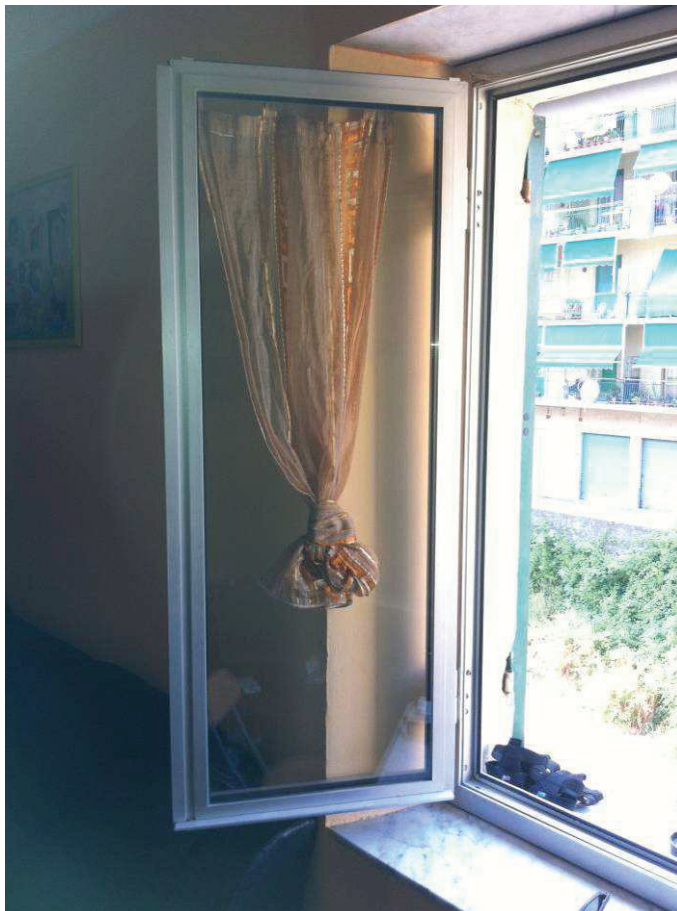
Foto 15: particolare degli infissi
