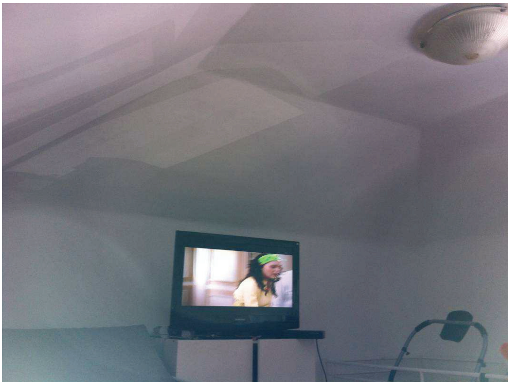
Foto 13: particolare del soffitto
