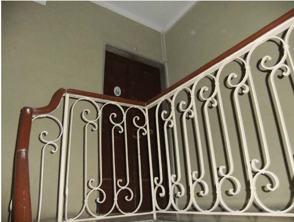
Foto n° 5 – Vista accesso appartamento – portoncino ingresso
