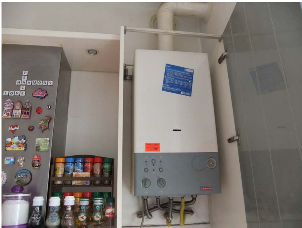
Foto n°14 – Vista interna – impianti e finiture
