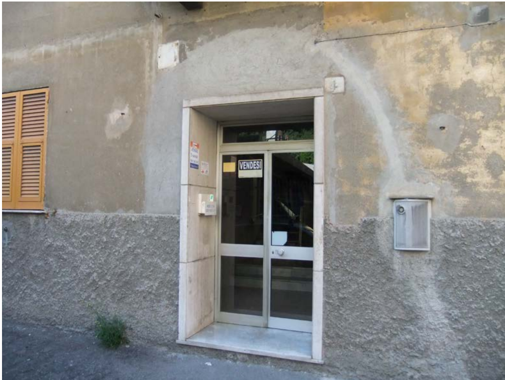
Foto n° 3 – Ingresso all'immobile condominiale
